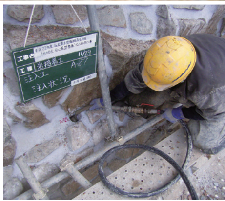
3 DKボンド注入工 圧力はかけずにモルタルの自重による浸透で亀裂奥の空隙を充填させていく
