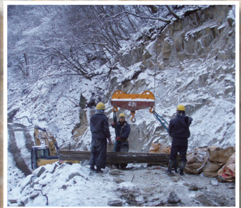
5 資機材撤去 冬から春にかけて横湯川の水位の上昇が予想されるため、資機材は一時撤去した
