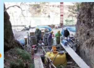
注入機械は道路わきや作業構台上に設置。注入量の管理は流量計により行う
