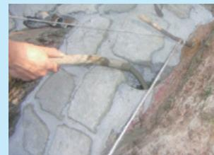
目地施工時に設けた注入孔より注入用モルタルを自然落下で流し込む
