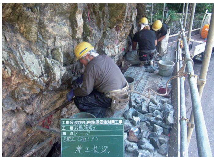
現地では、岩石上部の立ち木に太さΦ18mmの親綱を縛り垂らしたうえで、安全帯を装着した作業員が親綱を伝って斜面を降りていく。まず、斜面上で施工範囲を測定し面積を求めるため上部に1名、斜面上に1名、道路上に1名に分かれて巻尺を用いて測定した。
