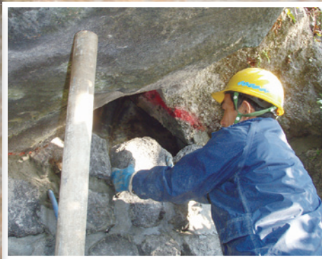
4 DKボンド目地工 現地の石を積みながら、石と石の間にモルタルを詰めていく。
