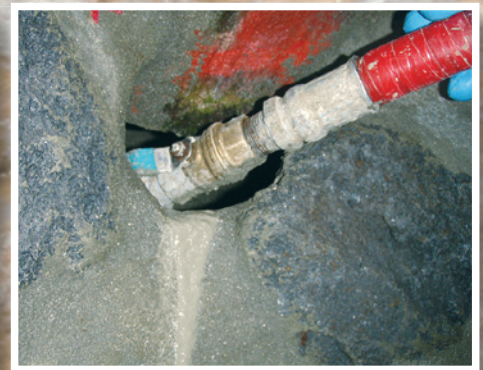
5 DKボンド注入工 専用機械により練り上げたDKボンド注入モルタルを、亀裂の奥に注入していく作業。
