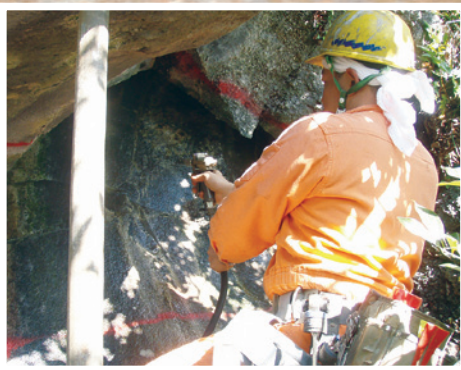
3 清掃並びに水洗い工 清掃や水洗いをきちんと行うことで、亀裂の形状を正確に把握することができる。
