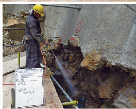
3 水洗い工 高圧洗浄機により水洗いし、不純物を取り除く。
