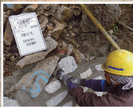
4 DKボンド目地工 熟練作業員により慎重に目地詰め作業を行う。
