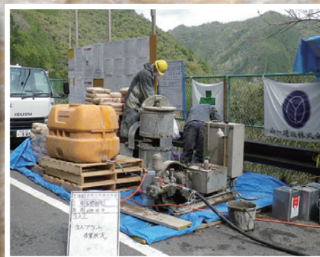
5 DKボンド注入工 道路脇に設置した注入機械によりDKボンド注入モルタルを送る。
