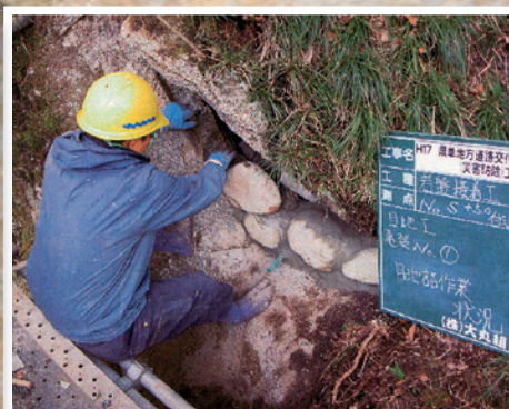
4 DKボンド目地工 人の手で丁寧に石片を積み上げる。
