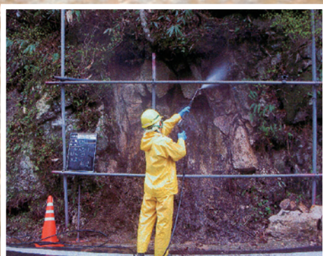
3 水洗い工 接着効果がより高まるよう、高圧洗浄機で水洗いする。
