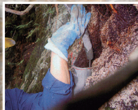
5 DKボンド注入工 注意深く、注入状況を確認しながら作業を進めた。
