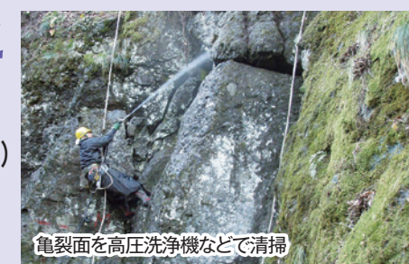
亀裂に沿って土砂・木の根・苔などをワイヤーブラシ等で取り除く
