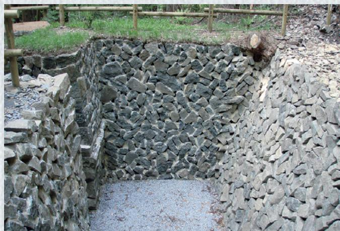
ンドモルタルで充填するのではなく、一部分にボンドモルタルを詰め全体を連結させる事で安定させる手法を提案させていただき、採用となりました。
