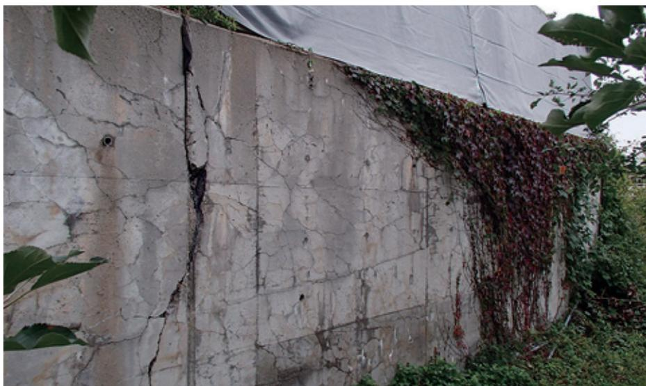
範囲内のクラックの延長を計測し、ハツリ工及びDKボンドの使用量を算出した。現地で計測した数量を基に施工量を算出と施工金額を積算したうえで、設計会社の担当者に提出した。
