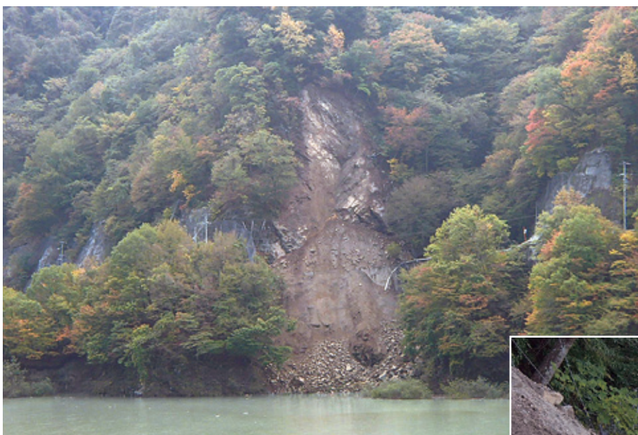
対岸から崩落現場全体を確認
