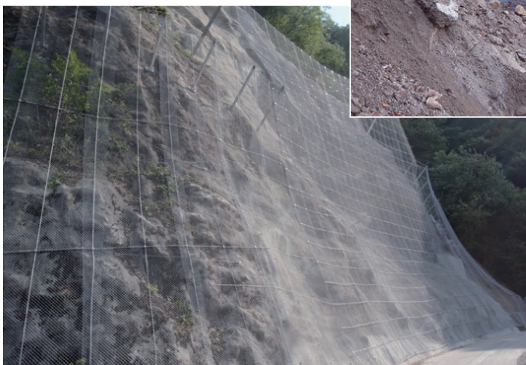
工事はすべて完了し、復旧した県道。
