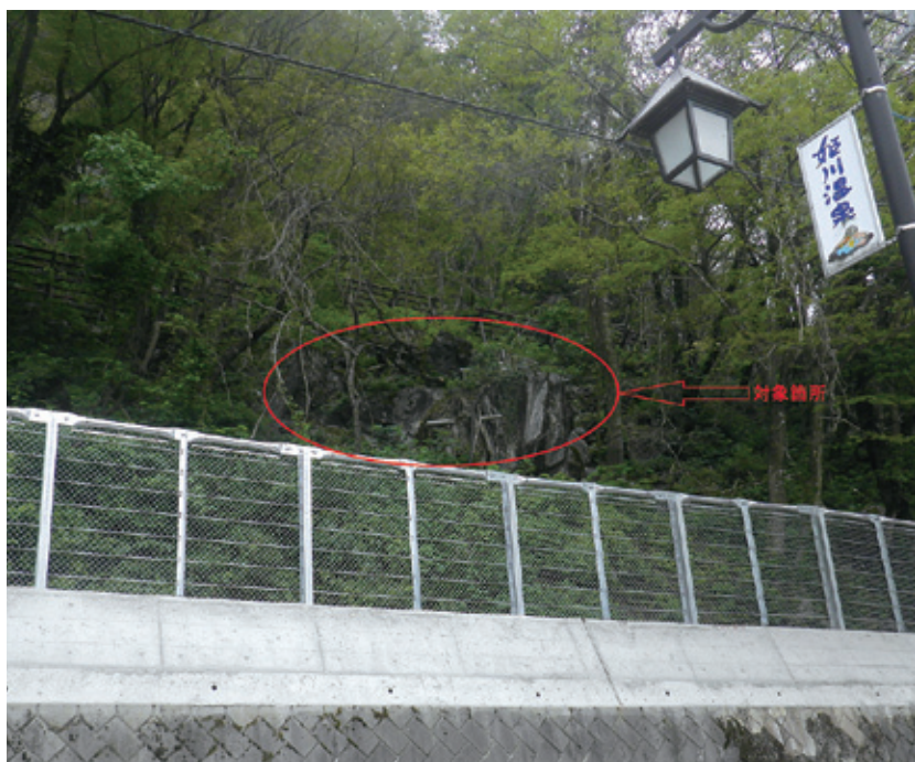
対象箇所を道路上より見上げる。写真中央部の木々の中から除く岩。
