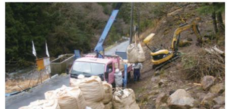
クからFブロックまでの6箇所を確認。それぞれの岩塊において、斜面上部より親綱で斜面を下りながら3人が亀裂寸法を計測し、1名が記録していった。また不安定な岩塊の大きさ(長さ、幅、奥行き)と、接着する安定した基岩の勾配を計測し、DKボンド工法による安定化を事前に確認する安定計算を行った。
