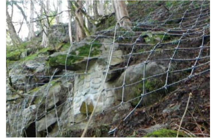
全体をロープネット工で抑えてDKボンド工法と併用した
