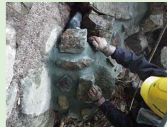
DKボンドモルタルに着色剤を配合した着色モルタルにて施工した。 (着色剤は黒、緑を混合して配合)
