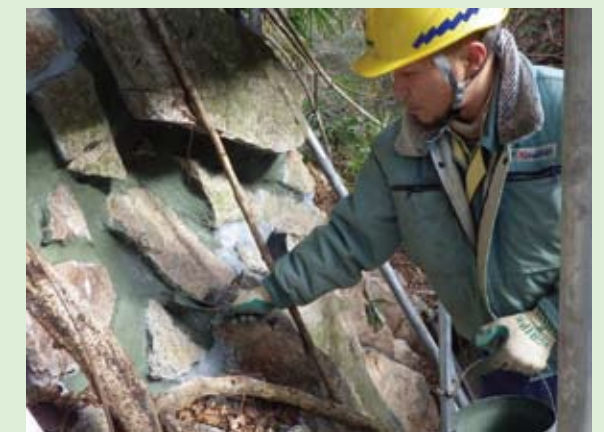
DKボンドモルタルの表面部に着色剤を塗布し、色の浮き上がりを抑制した。
