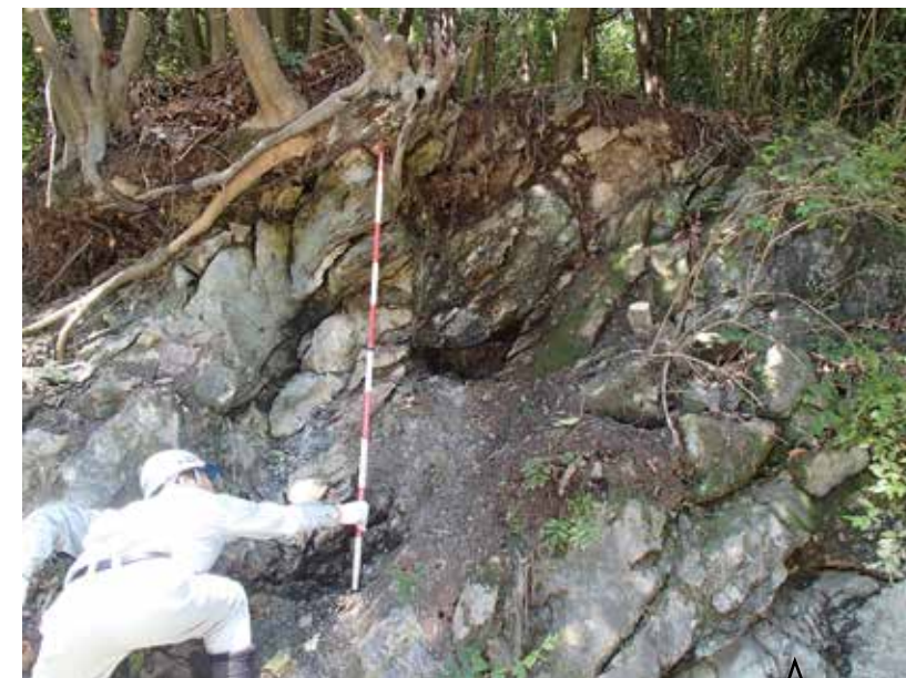
崩落源周辺の巨大な岩石を測定し、施工範囲を想定する
