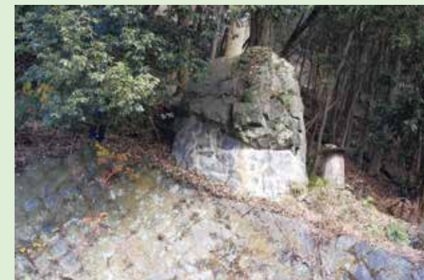
施工後。巨岩は安定している。
