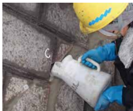
亀裂の奥に注入充填し、構造物が一体化となる
