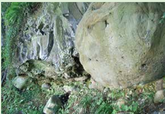
施工前。写真下側にDKボンドモルタルを充填した。
