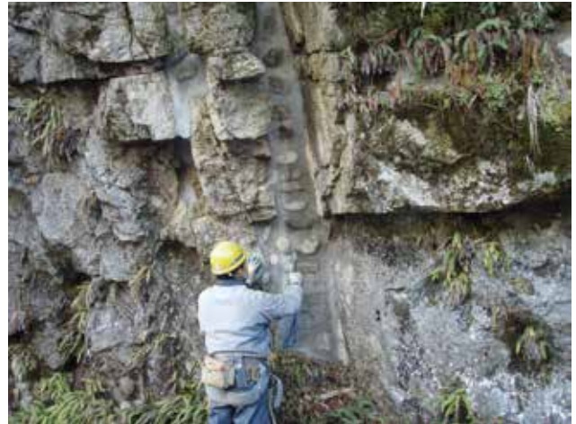
施工2年後に施工箇所を点検。接着力は維持されていたが、更なる景観性が課題となった
