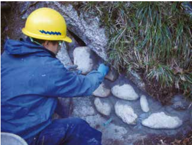
施工中の様子。幅の広い亀裂に石片を積みながらモルタルで接着していく
