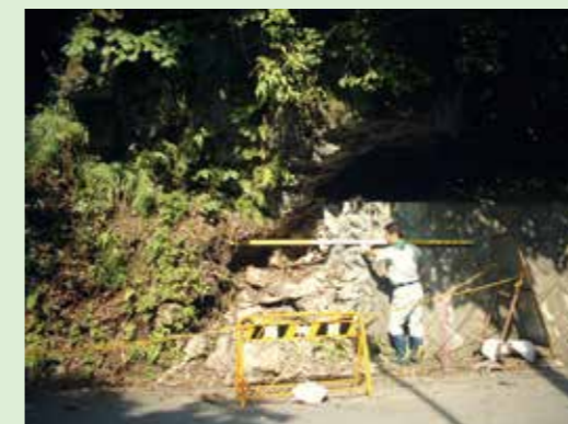
亀裂およびオーバーハング部の寸法を計測し、DKボンドモルタルの充填量を把握します。
