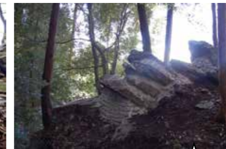
施工後。岩塊は接着安定化し、崩落の心配がなくなった
