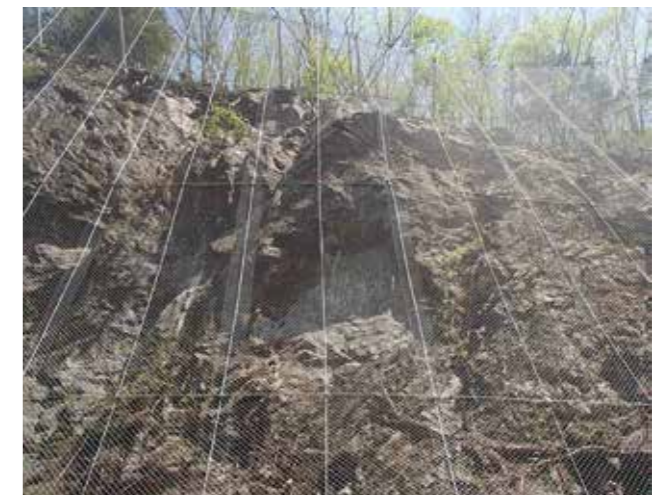
施工完了後。全体がロックネットで覆われ、写真中央部にDKボンドモルタルが充填されている
