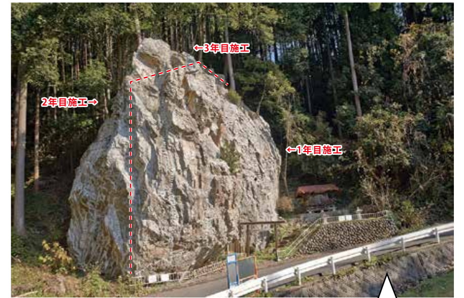
施工箇所全景。写真中央部の道路に最も近い箇所が1年目施工。中央部上側と写真左側の側面部分が2年目施工。写真では確認できないが今回は右側の最上部を施工
