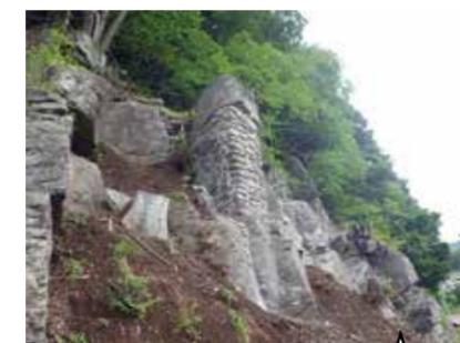
施工完了後。不安定な巨岩の空隙部をボンドモルタルで接着し、一体化させた
