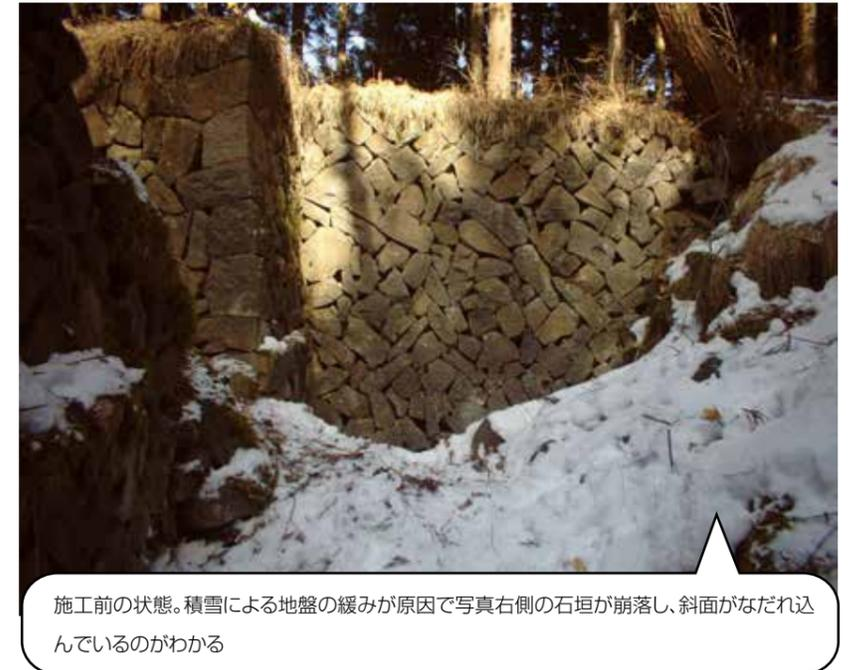
施工前の状態。積雪による地盤の緩みが原因で写真右側の石垣が崩落し、斜面がなだれ込んでいたのがわかる
