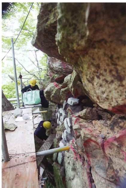
安全に配慮した仮設防護柵や簡易索道、仮設足場等を設置したうえで施工を行った
