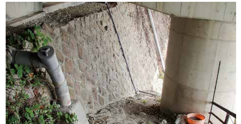
最も湧水の多い箇所を中心に施工対象として空隙部にDKボンドを充填。全体を接着一体化することができた
