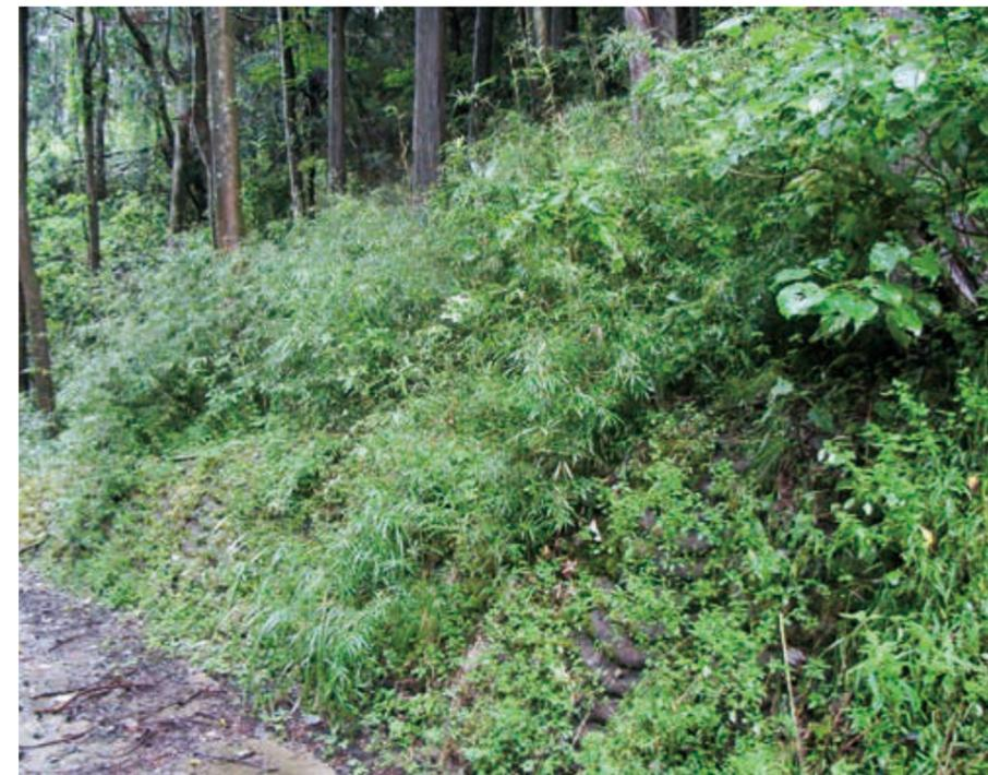
箱根の山中(国立公園内)で施工した森林表土利用工。施工4年後の植生状況は写真のとおり。調査の結果、44種の地域系統植物が確認された
