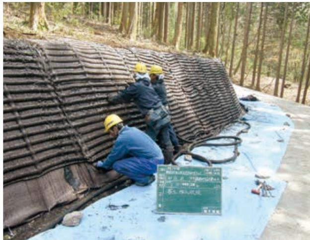
アンカーピンで布設した袋状マットに植生基盤を注入する「植生基材注入状況」の写真
