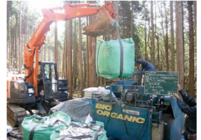
「植生基盤攪拌状況」の様子。専用の機械で肥料、生育基盤材等を水と混合して植生基盤材を現地で作成
