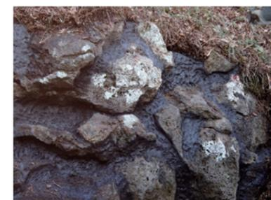
あえて表面に凹凸をつけてDKボンド目地工を施工
