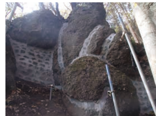
挟まれた状態の岩塊が DK ボンドによって接着安定化
