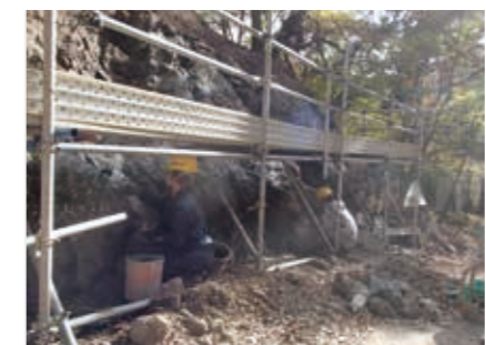
破碎後の斜面を追加施工した
