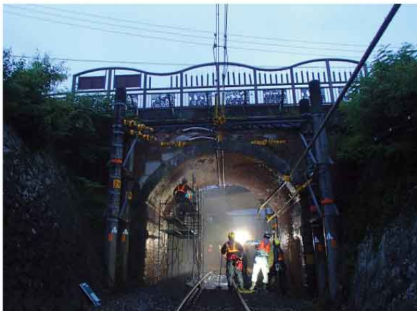
夜間での洗浄、プライマー塗布、ポリウレア樹脂吹付作業状況
