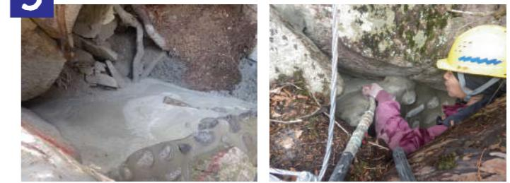
高さ 2 m ずつ根固めの作業を数回にわたってを行い、DK ボンドモルタルを注入していきます。目地の施工時に設けておく注入孔より注入用のモルタルを自然流下で流しこみます。
