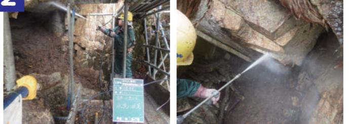
高い接着効果を維持するために、亀裂内に蓄積した土砂や草木苔などを取り除き、高圧洗浄機によって洗浄します。
