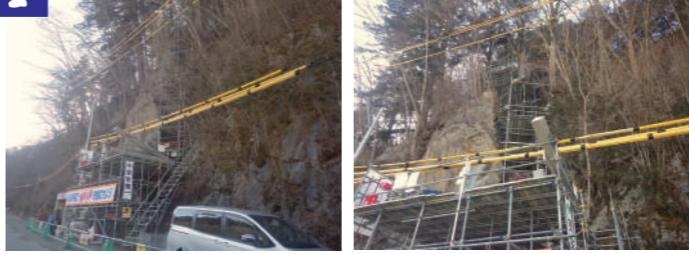
崩壊した斜面に沿って作業足場と資材置場となる作業構台を設置します。
