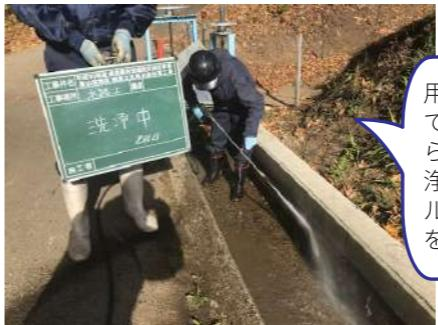
用水路は長年の水流によって、表面のコンクリートが削られて凹凸に…。まずは、洗浄をしてきれいにしてからモルタルでならし、プライマーを塗布して…
