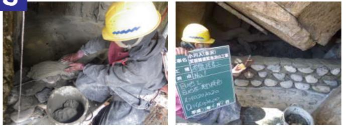
DK ボンド工法モルタルと現地石片や購入石材を、手作業で丁寧に交互に積み上げ根固めの作業を行います。石積みの厚みは 20 cm を標準とします。
