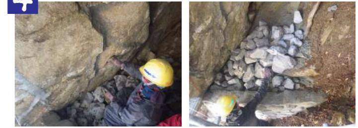
注入モルタル充填部に石片を敷詰め、使用材料の低減と作業効率の向上を図ります。
