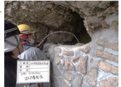
DK ボンド目地モルタルと石片を手作業で丁寧に交互に積み上げます。石積み厚みは20cmを標準とします。高さ2mずつ数回にわたって目地工の作業と、DK ボンド注入工を繰り返します。
