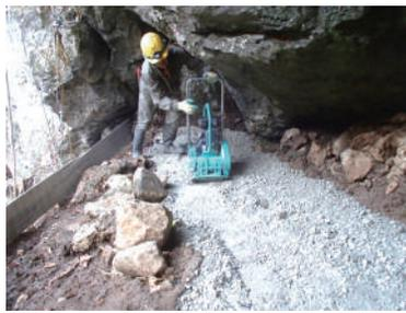
DK ボンド目地工の基礎となる部分の根固めすることにより、安定化を図ります。掘削後グラッドセルを設置し、砕石を敷均し、転圧をして基礎工の完了です。
