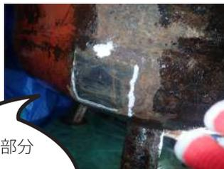
まずは、腐食していた部分を鉄板で塞ぎ補修。
