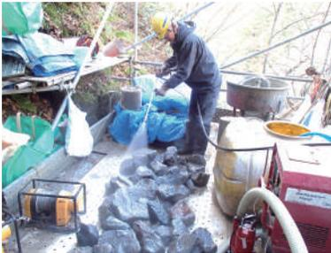
高い接着効果を維持するために、空隙部に蓄積した土砂や草木苔などを取り除き、岩盤の表面や石片を高圧洗浄機によって洗浄をします。
