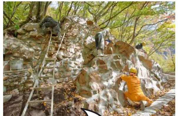
斜面勾配が約40度だったため、仮設足場は設置せず、作業は脚立や上部の立木より親綱を斜面上に垂らし施工。
