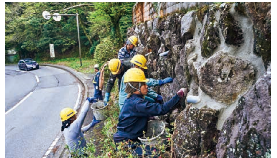
神奈川県箱根町では景観性を考慮した着色仕上げによる修景作業を実施(第45号)
