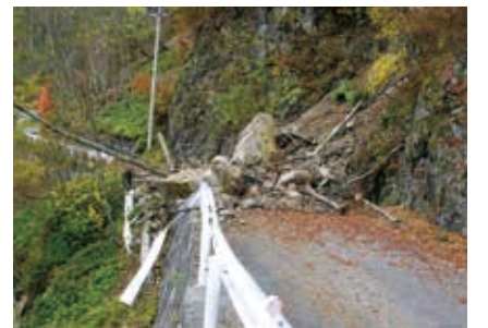
第2号掲載の長野県飯田市「しらびそ峠」は災害現場の復旧と斜面安定化対策の事例
