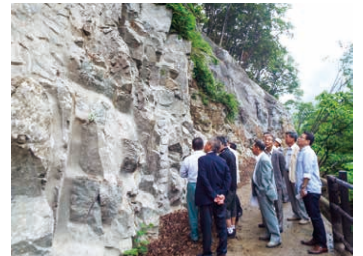
DKボンドモルタルで落石対策を施した上高井郡高山村「舞の道遊歩道」で現地視察会
