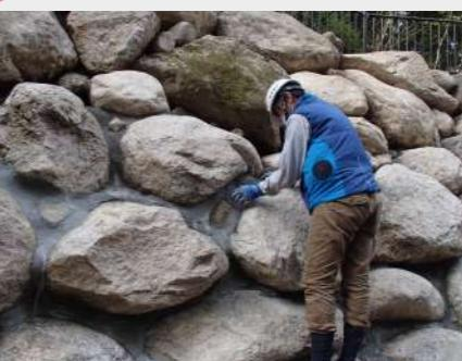
巨石積みの隙間にDKボンド目地モルタルを丁寧に手作業で埋めていきます。巨石を一体化させ、強度を増すための重要な工程です。
