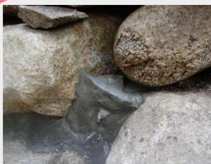
下部から巨石の裏側の空隙部に、注入用モルタルを流し入れていきます。空隙間がそれほどなかったため、今回は注入機械ではなく、空隙部に合せ調整しながら人力により流し入れていきました。
