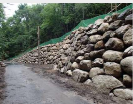
高い接着効果を維持するため、空隙部に堆積した土砂や草木苔などを取り除き、巨石や石片の表面を高圧洗浄機によって洗浄します。
