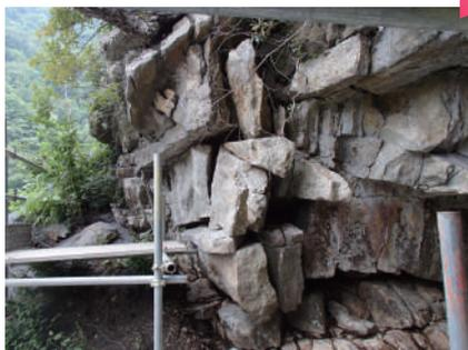
高い接着効果を維持するために、空隙部に堆積した土砂や草木苔などを取り除き、岩盤の表面や石片を高圧洗浄機によって洗浄をします。
