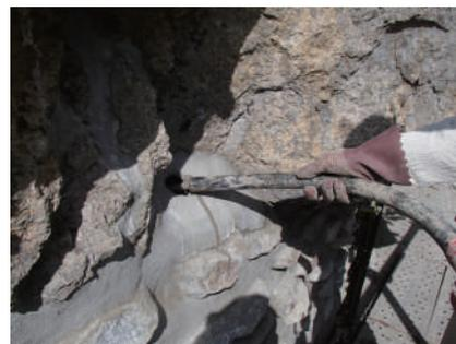
下部から高さ2mずつ数回にわたって目地工の作業を行い、KDボンド注入工を繰り返します。最後はホースが入るぐらいの小さな口から注入し、充填したらモルタルで口を埋めて完成です。
