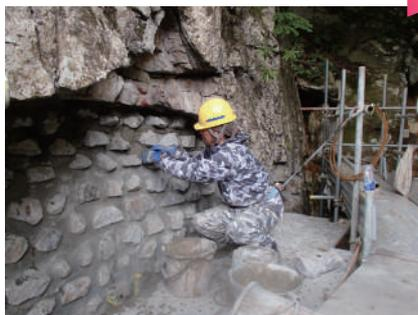
小亀裂部はワイヤーブラシで土砂を取り除き、目地詰めを行います。大亀裂部は石片とDKボンド目地モルタルを手作業で、20cmの厚み（標準）で丁寧に積み上げていきます。
