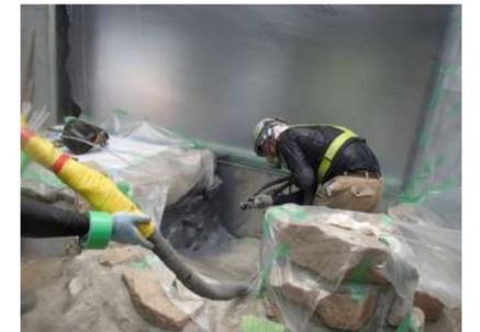
プライマーを塗布し、ポリウレア樹脂を吹付けていきます。速乾性が特長で数秒で硬化しはじめます。
