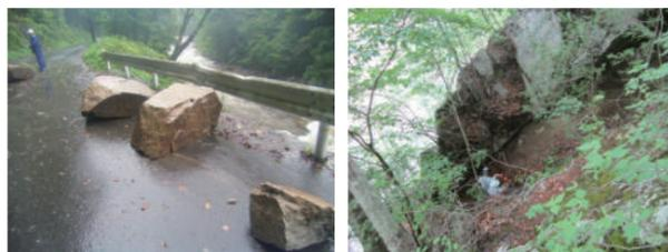
▲崩壊斜面より落下した転石 ▼落石発生と推測される箇所
