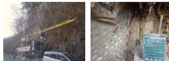
▲崩壊した斜面に沿って作業足場と資材置場となる作業構台を設置 ▲数回にわたり石積み、目地モルタル、モルタル注入を繰り返します。
