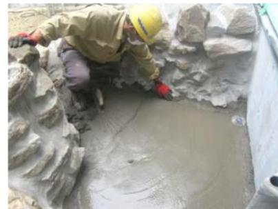
底面をモルタルで埋めて、水深を調整しDK ボンド工法の作業は完成です。
