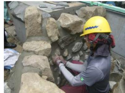
石と石の隙間を手作業でDK ボンド目地モルタルを丁寧に詰めていきます。
