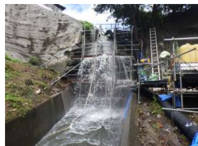
▲雨の翌日には河川水量が増し仮排水管からあふれ施工箇所流れ落ちる事も。
