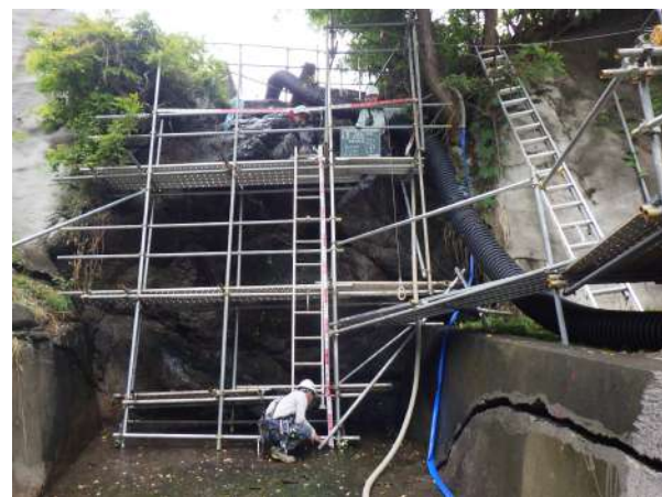
▲雨の翌日には河川水量が増し仮排水管からあふれ施工箇所流れ落ちる事も。
