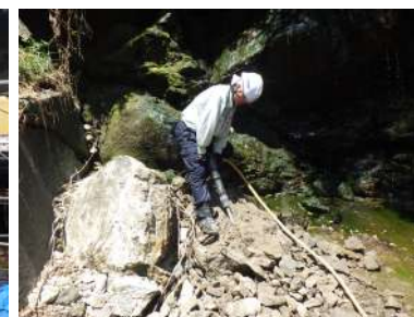
▲落石の破碎状況
