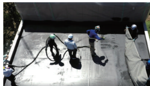
▲上空からのポリウレア樹脂吹付状況
