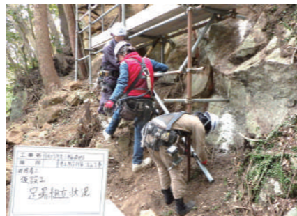
▲岩盤の斜面に沿って足場組を行います
