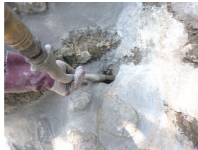
▲注入モルタルで一体化となり崩壊を防止します。
