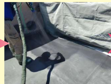
▲ポリウレア樹脂を均一に吹付けていきます。厚さは2mm程度です。吹付けて数秒で硬化し始めます。
