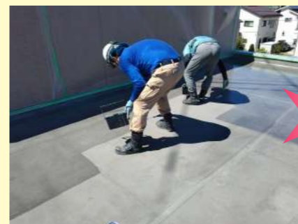
▲既存防水層表面の付着物を取り除ききれいに掃除をします。その後プライマーを塗布し接着効果を高めます。
