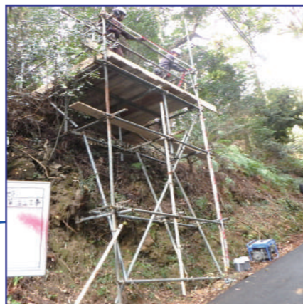
▲道路沿いの比較的開けた場所に資材置き場となる作業構台を設置
