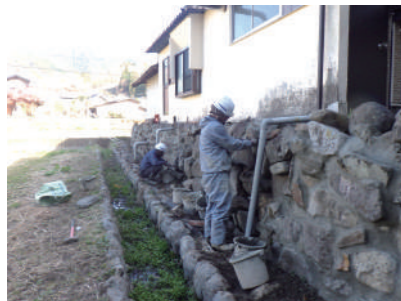
▲DKボンド目地モルタル詰め状況
