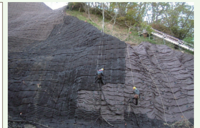
▲ソウケンフォーム布設、植生基盤材圧送状況
