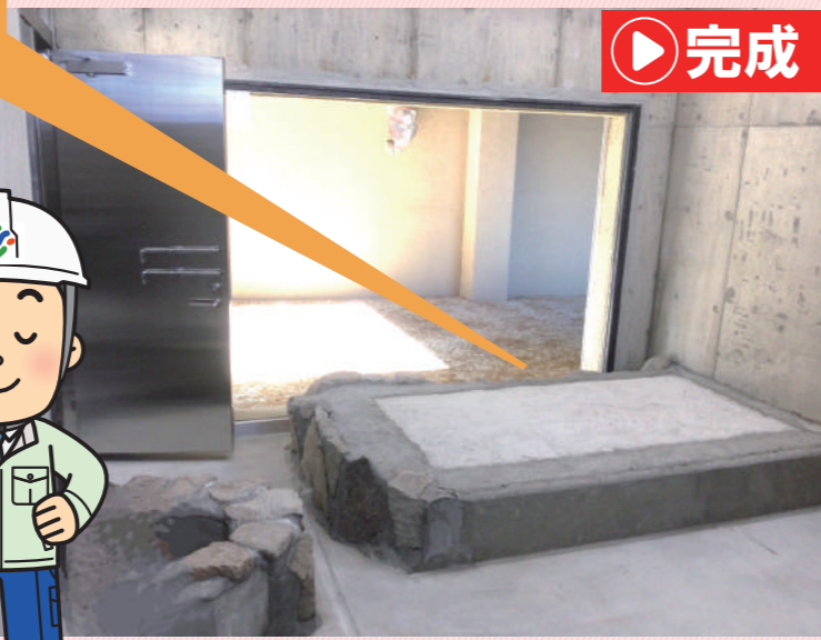
▲展示室内側からの写真。流し場も自然石で積み上げています。
