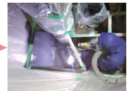
▲モルタルが乾いたところで養生をし、ポリウレア樹脂を吹付けます。
