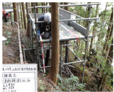
▲資材置き場となる仮設構台を設置
