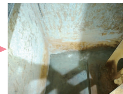
▲速乾性のある止水モルタルで漏水部分を埋めていきます。
