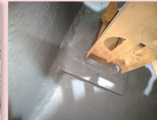
▲速乾性のある止水モルタルで漏水部分を埋めていきます。
