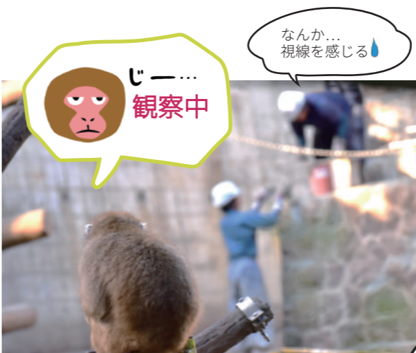
▲空隙部分に DK ボンドモルタルを流し込みます。
