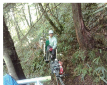
▲モノレール設置状況
