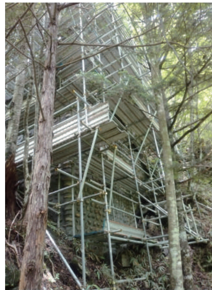
▲足場設置状況
