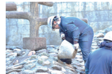
▲空隙部分に DK ボンドモルタルを流し込みます。
