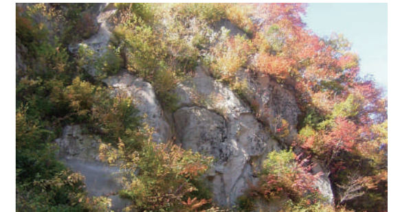
▲工事完了から5年後の現場です。〈富山県黒部市仙人谷ダム管理所〉
