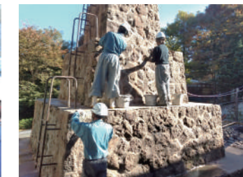
▲丁寧に DK ボンド目地モルタルを詰めていきます。
