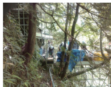
▲作業構台設置状況
