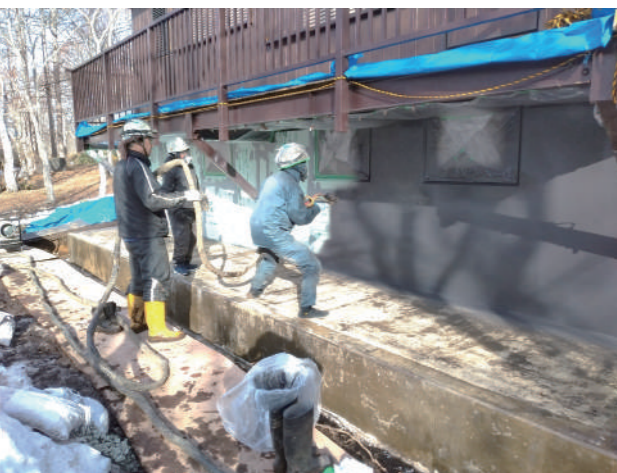
◀コンクリート壁面にはプライマーを塗布後ポリウレタ樹脂を吹付けますが、ポリスチレンフォームはポリウレタ樹脂と密着性が高いため直接吹付けることができます。
