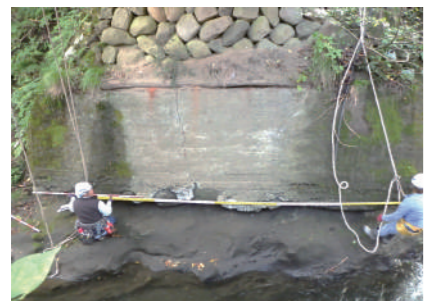
▲ 現場調査状況
