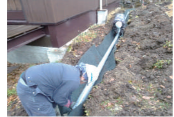
▲暗渠排水設置状況。幅 0.6m 深さ 0.6m ほど掘り、吸出防水シート、暗渠パイプ 100φ を設置し埋設。
