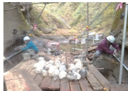
▲ 作業ヤードでの根固め作業状況
