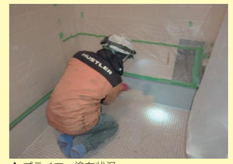
▲プライマー塗布状況
