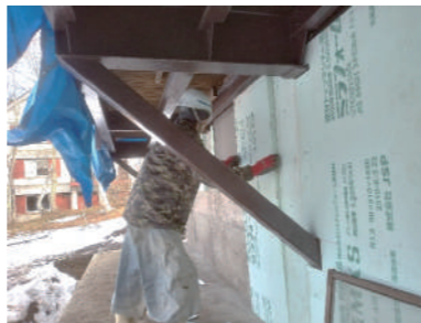
▲半地下部分の外部と内部間仕切りのコンクリート面に厚み 50 mm のポリスチレンフォームをビス止めし、つなぎ目は防水テープやパテ処理をして整形します。
