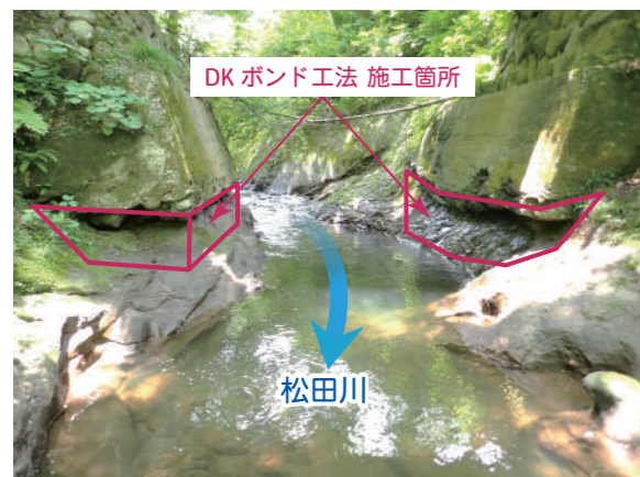
▲ DK ボンド施工箇所
