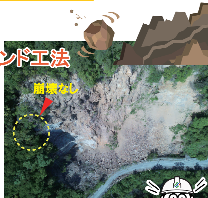
▲地震発生時の斜面崩壊状況
