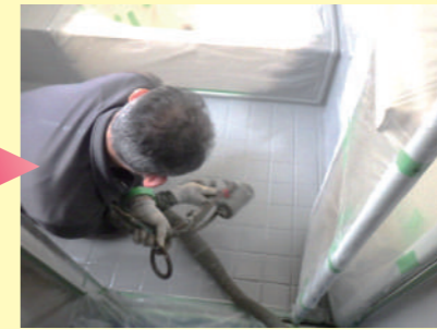
▲2液を化学反応で生成するポリウレア樹脂は瞬時に硬化し基材に定着します。
