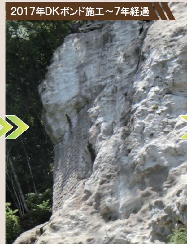
▲施工後、DKボンド工法以外の周辺に吹付を行う
