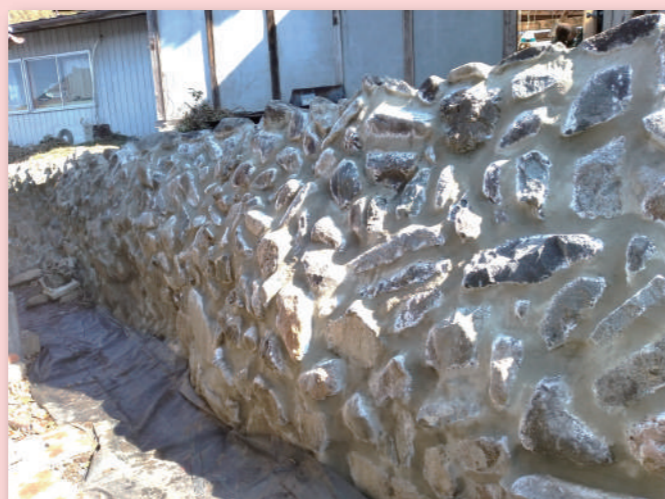
▲膨らんだ状態で目地工、注入工を行い石積み全体が一体化されました！
