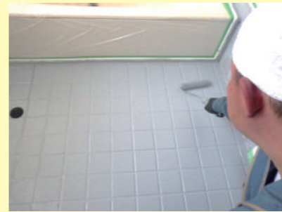
▲はじめにタイル表面の洗浄を行い、下地のプライマーを塗布します。
