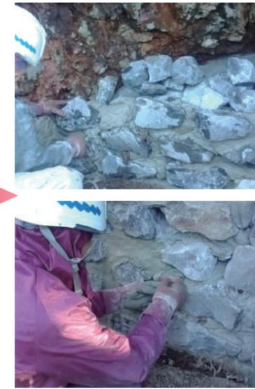
先に石片とDKボンドモルタルを交互に積み上げ、その後隅間に丁寧に手作業でモルタルを埋めていきます。石積みを一体化させ、強度を増すための重要な工程です。
