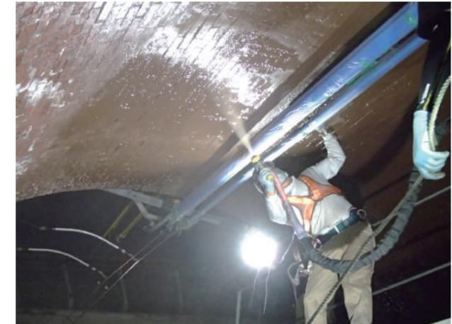
▲表面を洗浄し、プライマー塗布。ポリウレア樹脂を吹付けていきます。
