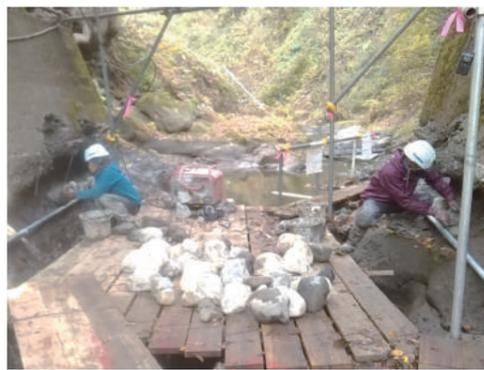
DKボンド工法は人力作業が主体となる施工で、工事設備等が軽微なため、現場の広狭や施工場所の状況に合わせて柔軟に適用ができます。また、所定の配合で練り混ぜたDKボンドモルタルは、亀裂壁面や根固めに充填接着をさせていただきますが、接着性が高いため耐久性が期待できます。現状のまま、自然石をベースとした景観を将来的に維持したい場合などには有効な工法と言えます。
