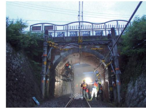
▲最終電車の通過を待ち、足場の設置から開始。始発電車までの限られた時間内での夜間作業です。
