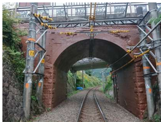
▲JR中央線上のレンガ剥離対策として橋梁補修
