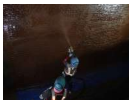
▲JR中央線上のレンガ剥離対策として橋梁補修
