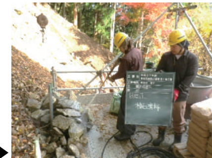
積石採取、洗浄状況▶
