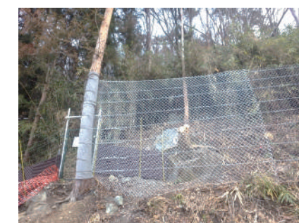
▲仮設防護柵を設置してからDKボンド工法の施工に入ります。
