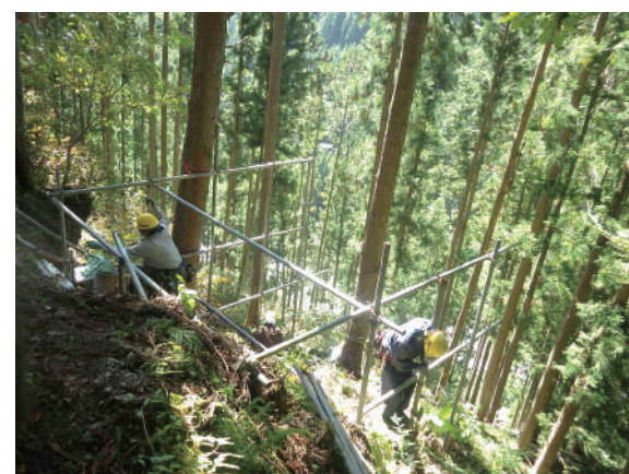
▲どんな急斜面でも、作業構台や足場を組み立てていきます。
