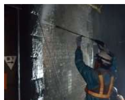
▲洗浄、ポリウレア樹脂吹付作業状況
