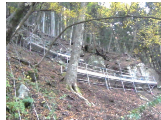
▲仮設足場の設置状況
