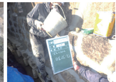
▲注入機械では、圧が高すぎて細部の空隙まで充填できないため作業で丁寧に注入していきます。
