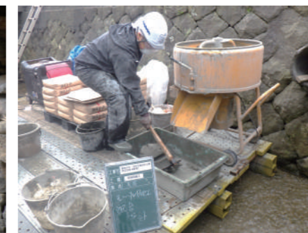
▲河川内に作業構台を設置するため、土嚢を積み上げることで水の浸入を防ぎながら施工。
