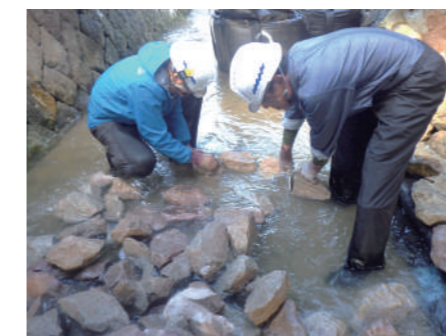
▲崩れた石は表面を丁寧に洗浄したうえで、再度積み直して復旧していきます。
