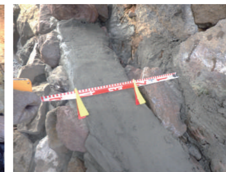
▲DKボンド工法による根固めは、目地モルタルと交互に200mm幅で積み上げながら施工します。
